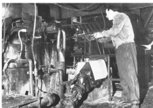
Lo spessore del rivestimento può variare da 20 a 66 grammi di stagno per mq.
